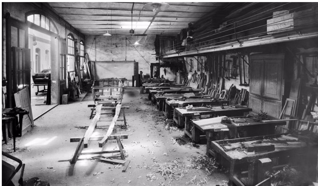
Figura 2. Carretería o carrocería de Juan Reynés en la calle Consejo de Ciento, 461-463 (actual 433) de Barcelona. Fuente: Palacín (2011).
