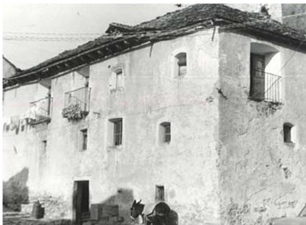
Figura 13. Casa Marcial, en el centro del pueblo (Lacort). Archivo Pablo Muro.
