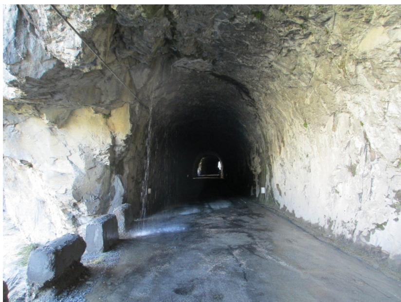
Figura 5. El difícil acceso a Plan: túneles de La Inclusa. Juan M. Rodríguez.
