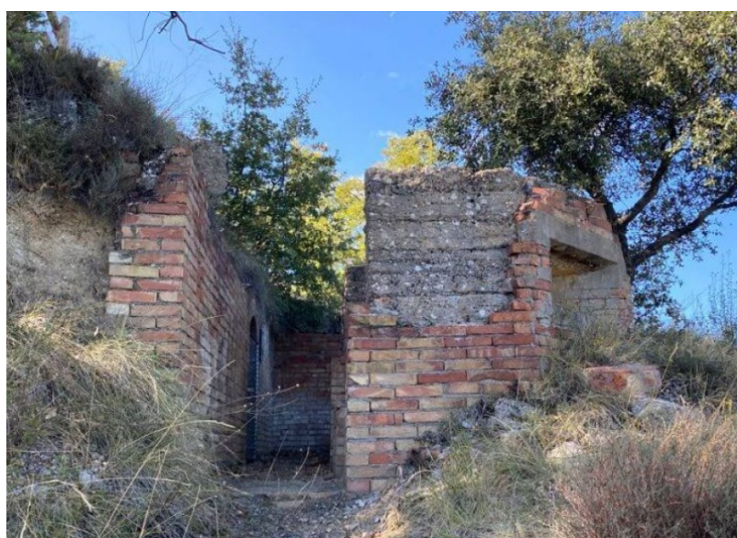
Figura 28. Trincheras de la guerra civil en Naval. Ayuntamiento de Naval.
