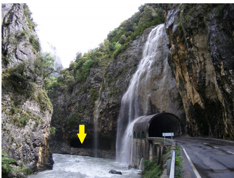
Figura 3. En pleno siglo XXI, el Paso de las Devotas sigue dando algún que otro quebradero de cabeza. La primera carretera (flecha amarilla) se puede ver todavía debajo del trazado de la actual. Juan M. Rodríguez.
