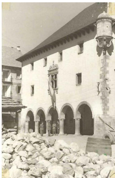
Figura 14. Ayuntamiento de Bielsa, edificio reconstruido por Regiones Devastadas . Fotografía anónima de 1954. Colección del autor.
