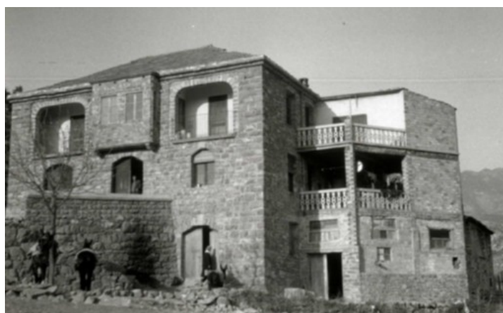
Figura 12. Casa Macario ( Macario Garcés, Panadería y Carnicería , como rezaba un calendario de 1957), Lacort. Archivo Pablo Muro.
