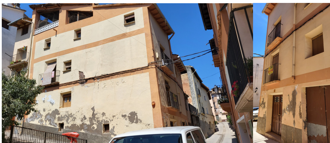
Figura 5. Casa Casolas de Naval, esquinera entre la Calle Mayor y la calle Nueva. Archivo Casa Susana.
