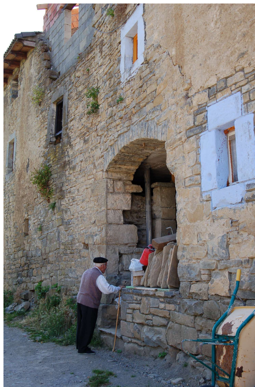
Figura 45. Antonio en la puerta de Casa Ferrero (Bergua), Juan M. Rodríguez.
