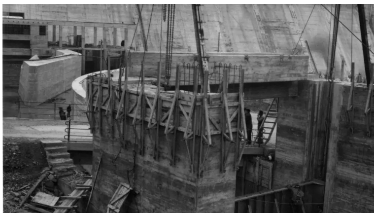
Figura 37. Obras del embalse de El Grado. CHE.
