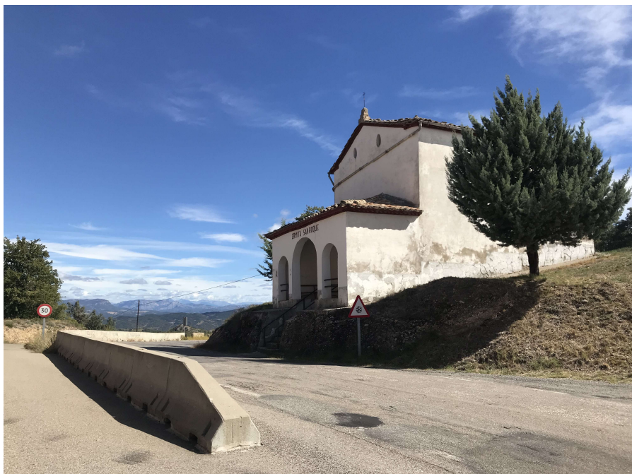
Figura 3. Ermita de San Roque en La Puebla de Castro, antiguo punto clave en las comunicaciones entre Barbastro y la Ribagorza. Juan M. Rodríguez, 2022.
