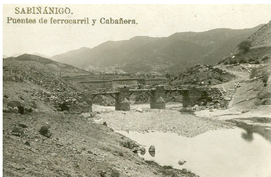
Figura 19. Sabiñánigo: puentes de la cabañera y del ferrocarril. Se avecina un cambio importante en la forma de vida. Postal (autor y fecha desconocidos). Archivo Julio Gavín.
