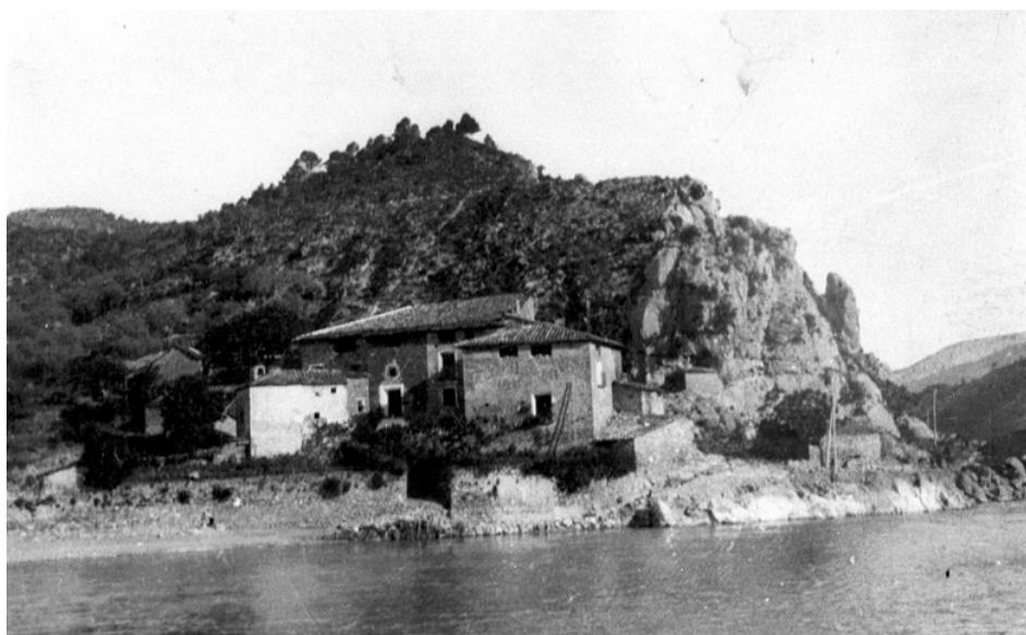
Figura 4. Imagen de las Casas de la Barca, antes de que se sumergieran bajo las aguas del pantano de El Grado. Fuente: CEDAS (Abizanda).
