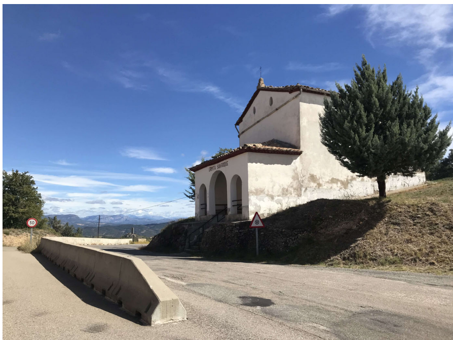
Figura 3. Ermita de San Roque en La Puebla de Castro, antiguo punto clave en las comunicaciones entre Barbastro y la Ribagorza. Juan M. Rodríguez.
